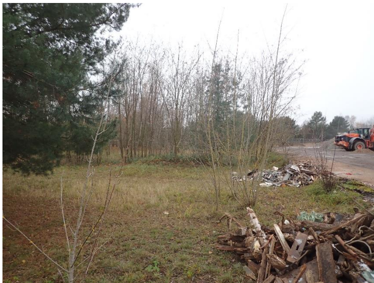
Bild 3-7 Südlicher Bereich des Baufeldes WA 8 mit Blick nach Südwesten, Stand 27.11.2023
