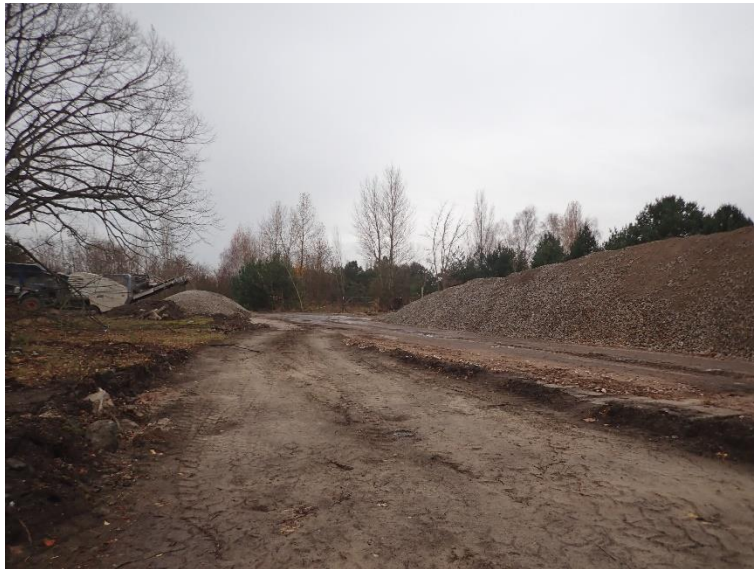
Bild 3-4 Südwestlicher Bereich des Baufeldes WA8 mit Blick nach Westen, Stand 27.11.2023
