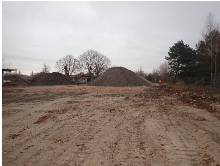
Bild 3-2 Westlicher Bereich des Baufeldes WA8 mit Blick nach Südosten, Stand 27.11.2023
