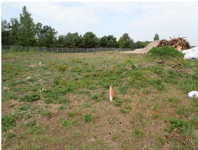
Bild 3-9 Südlicher Bereich des Baufeldes WA 8 mit Blick nach Südwesten, Stand 22.05.2024
