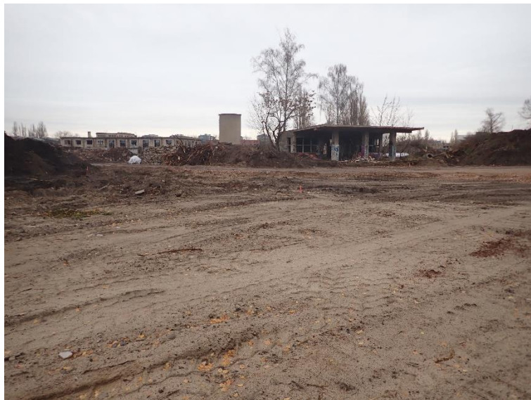
Bild 3-3 Nordwestlicher Bereich des Baufeldes WA8 mit Blick nach Nordosten, Stand 27.11.2023
