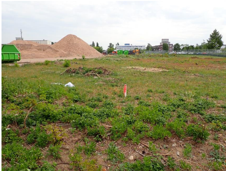
Bild 3-8 Südlicher Bereich des Baufeldes WA 8 mit Blick nach Norden, Stand 22.05.2024
